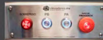
Dispositivo de seguridad que detecta la carga excesiva en la cabina.
